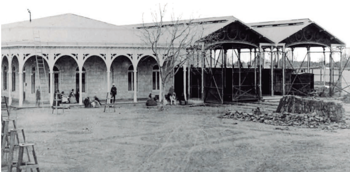
Primera estación del Ferrocarril del Sur, 1860.
