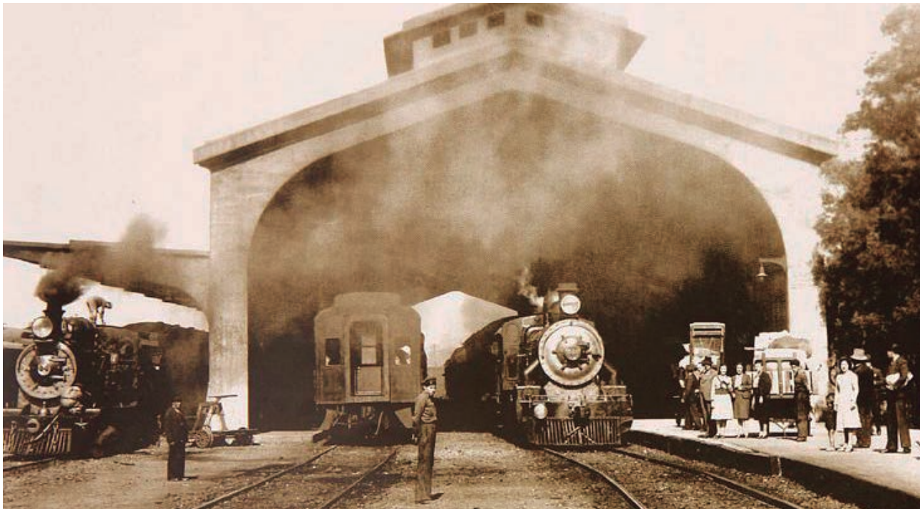
Estación de Talca, vista de locomotoras y ramal.
